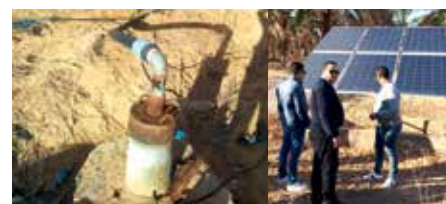
Système de pompage solaire
