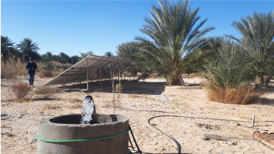
El sistema de riego por bombeo solar funciona mediante paneles fotovoltaicos. Gracias a la energía generada por estos paneles, la bomba se activa y extrae el agua disponible de las capas freáticas.
