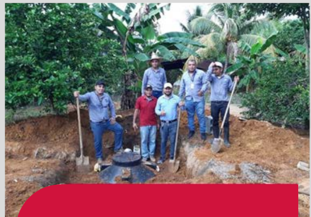
Biodigester installation. Source: Fundación Horizontes de Amistad staff photo. Septiembre 2021.
